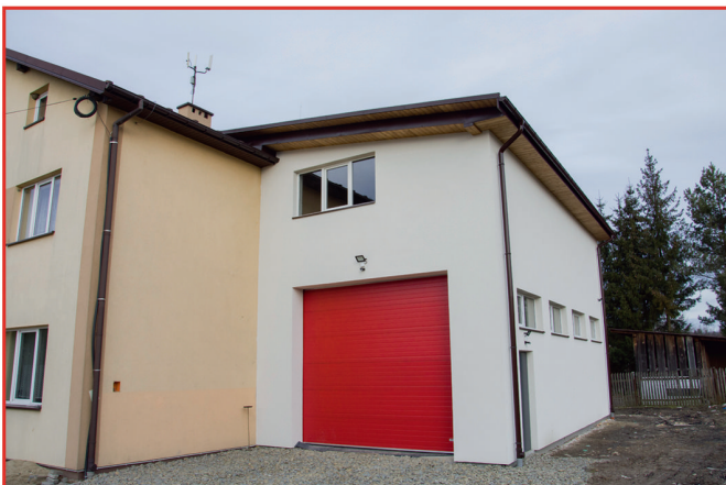
Strażnica OSP Stefkowa w trakcie rozbudowy
