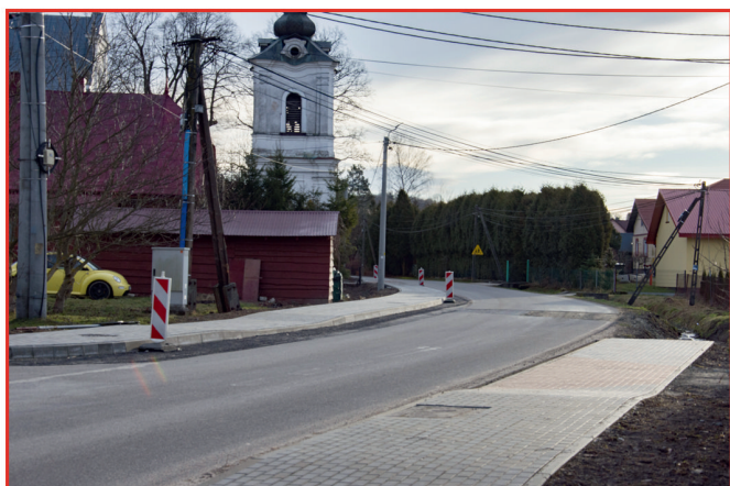
Trwająca budowa chodnika w Uhercach Mineralnych
