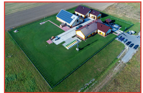
Oczyszczalnia ścieków w Uhercach Mineralnych
