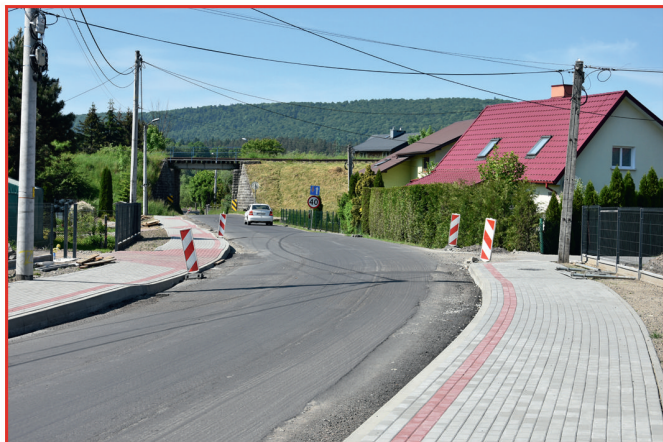
Ukończona już budowa chodnika oraz przebudowa drogi w Olszanicy
